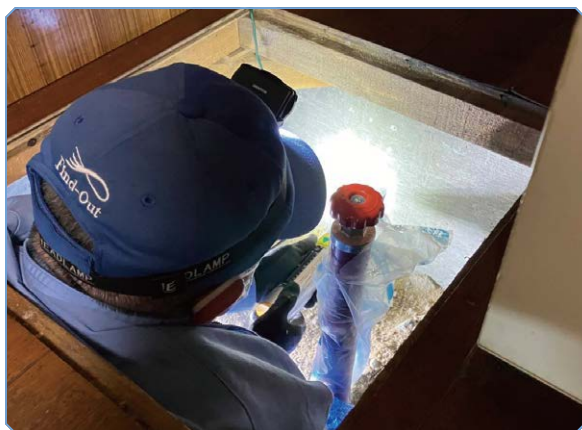
▲基礎コンクリート強度の確認
