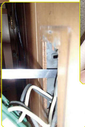
▶仕上げ材の厚み、間取り等の調査作業
