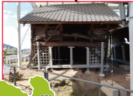
▲布田川断層帯が下に通る傾いた納屋。灰色の支柱は後から足されたもの。
