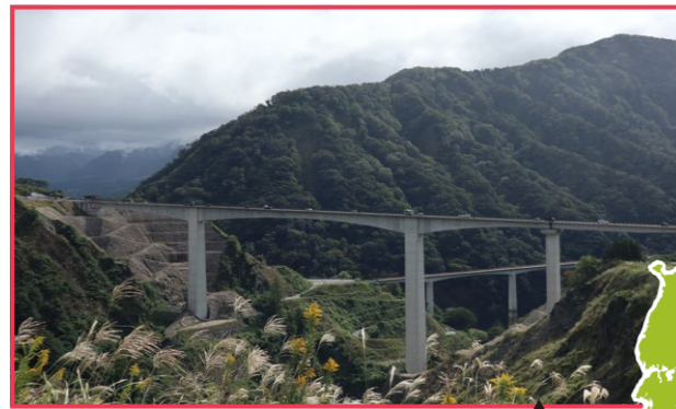
▲熊本市と南阿蘇村を結ぶ新阿蘇大橋は復興のシンボル
