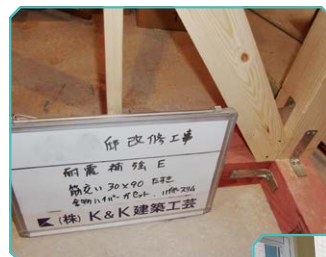
▲筋かいを用いた耐震補強工事
